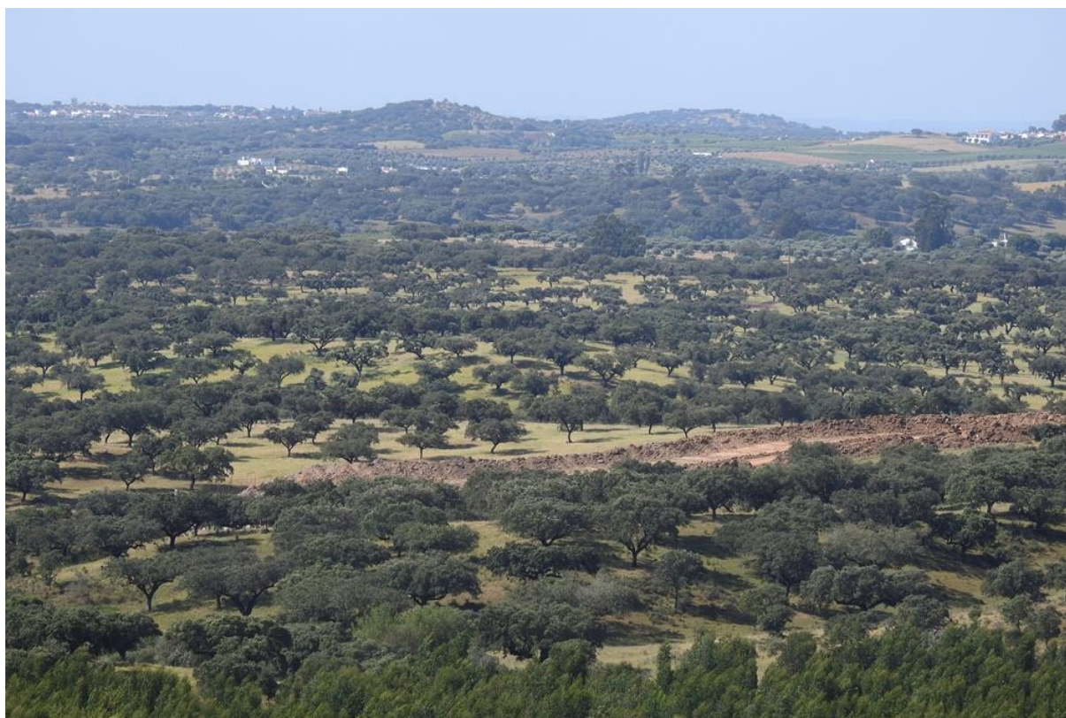
Figura 8 – Fotografia tirada do ponto RapFA2 no dia 28.05.2020, onde são perceptíveis os movimentos de terra resultantes da construção deste troço da ferrovia.
