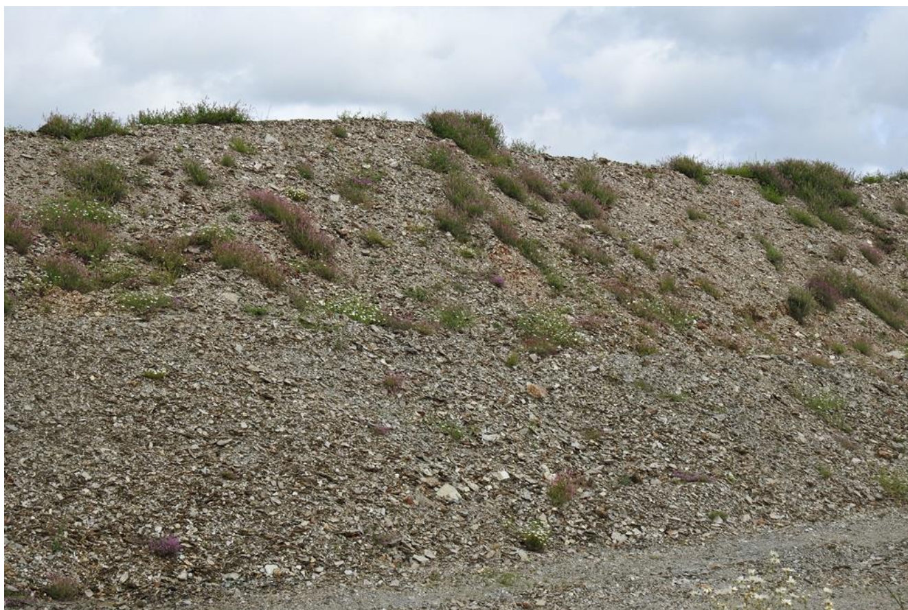
Figura 19 – Exemplo de taludes de aterro monitorizados na ferrovia, já com alguma vegetação remanescente mas sem espécies exóticas invasoras (Fotografia tirada no trabalho de campo)
